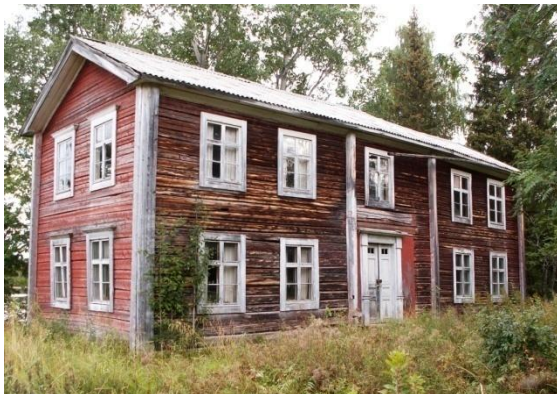
Mangårdsbyggnad fr V, Udden 1:6
