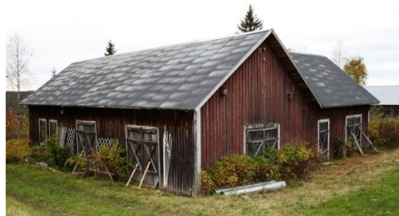
Ladugård fr Ö, Risliden 2:21
