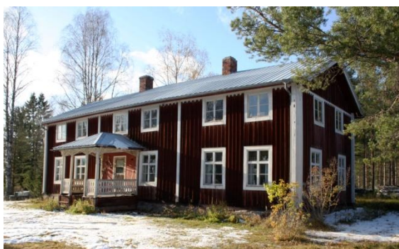
Mangårdsbyggnad fr Ö, Svanselse 1:45
