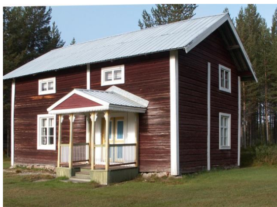
Mangårdsbyggnad fr SO, Haraliden 2:6
