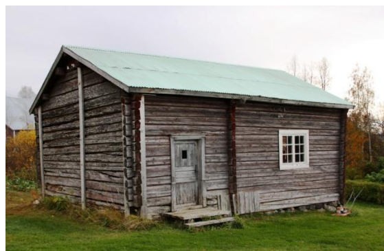
Fargångsstuga fr N, Risliden 20:1
