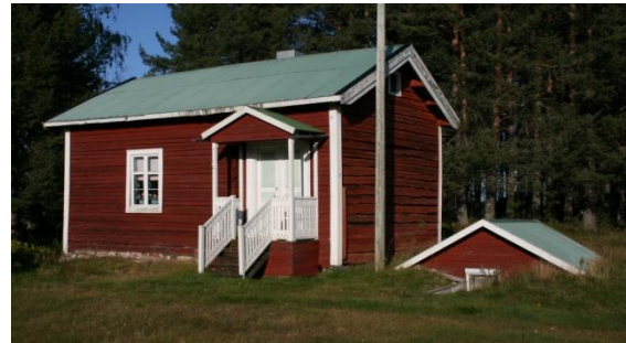
Bagarstuga och källare, Bastuträsk 2:11
