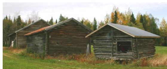
Ekonomibyggnader fr SV, Brännliden 1:2
