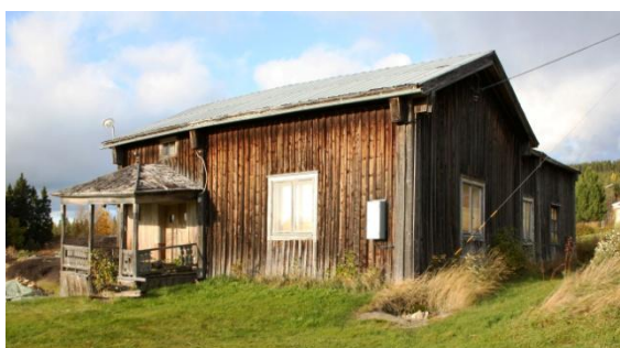
Mangårdsbyggnad fr S, Risliden 20:1
