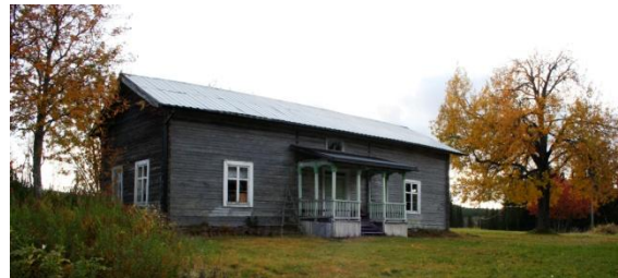
Mangårdsbyggnad fr N, Tvärliden 1:5
