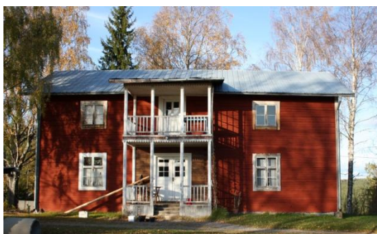
Mangårdsbyggnad fr S, Mörttjärn 1:3
