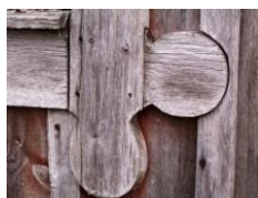
Fönsterfoder ladugård Udden 1:6
