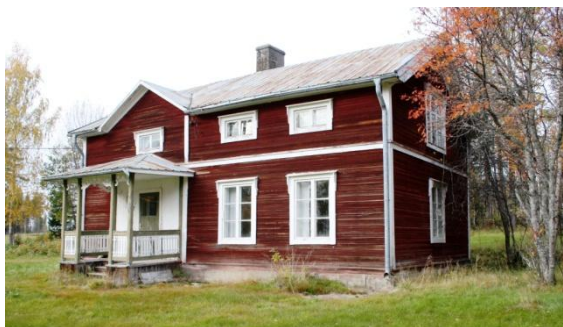
Mangårdsbyggnad fr SO, Finnleden 1:10
