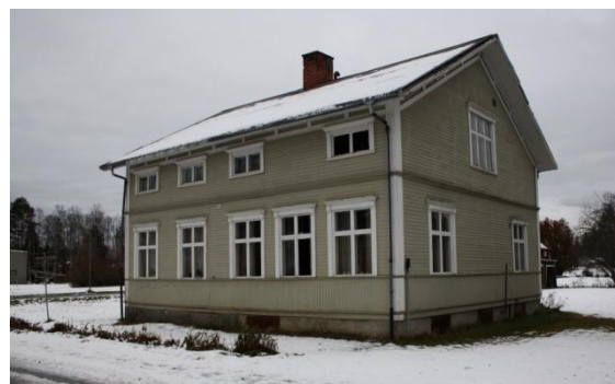
Mangårdsbyggnad fr NV, Bastuträsk 15:1
