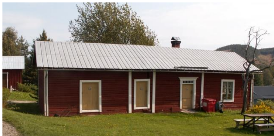
Bagarstuga fr V, Bastutjärn 1:27
