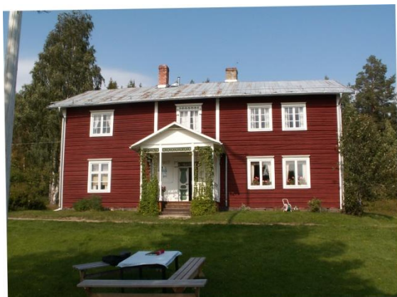
Mangårdsbyggnad fr S, Bastutjärn 1:27
